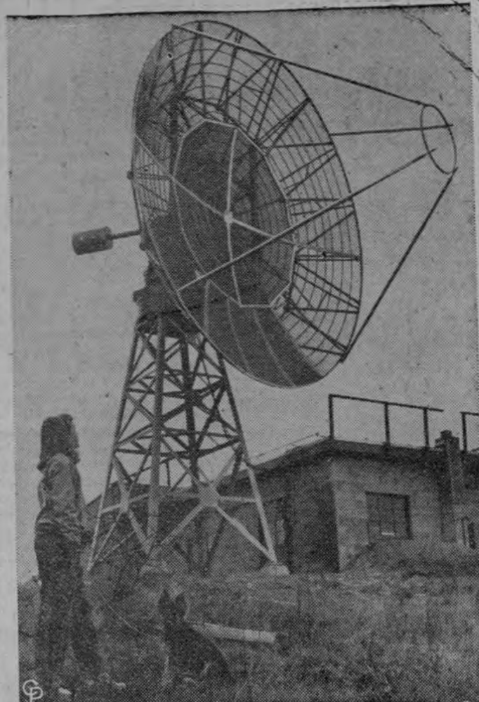
OBSERVANDO LA OPERACION. — Christine Piorowski y su perrito Nobby, no encuentran un rastro visible en Schenectady, N. Y. mientras el primer observatorio radio-óptico para un super-eficaz rastreo de los vehículos del espacio entra en operación. Un radiotelescopio (con una antena de 28 pies de diámetro) combina con un telescopio óptico de alto poder sensitivo con una cámara de televisión para "ver en la oscuridad". Los objetos tales como satélites pueden ser rastreados casi a mitad de su viaje a la luna. El observatorio se encuentra en operación por la división del laboratorio de ingeniería general de la General Electric.
